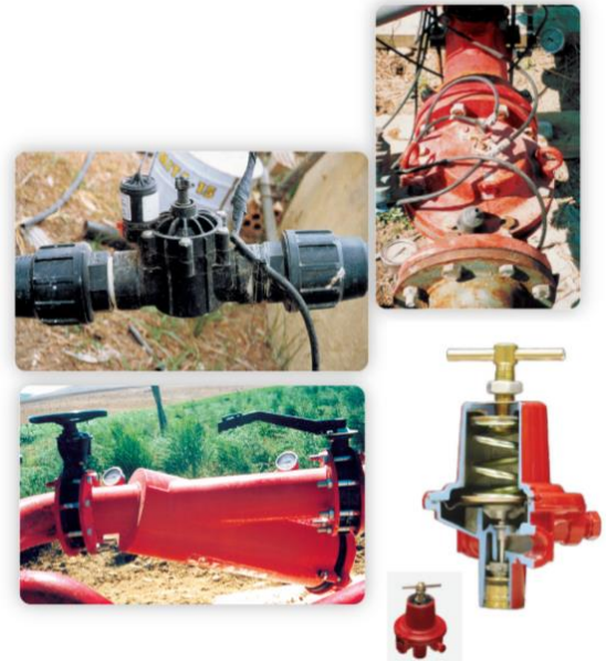
Ilustración 5. Elementos de control de una instalación de riego. Electroválvulas, reguladores de caudal, presión y válvulas de corte.
